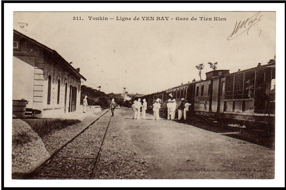
Tien Kien Train Station
